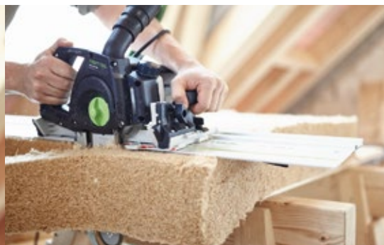
Rýdza presnosť: Presná, ľahká a hlboká na precízne prirezávanie dreva a izolačných materiálov – tesárska reťazová píla UNIVERS SSU 200.
